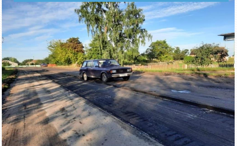
Ремонт дороги на ділянці Оленівка-Сокіл
